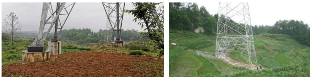
图5-1 不等高与铁塔长短腿基础现场图
