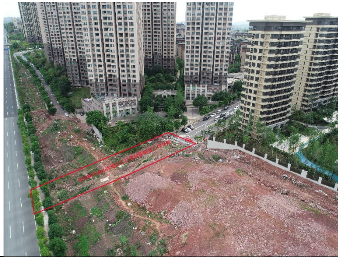
欣悦路与金山大道交汇口原预留电缆工作井段电缆通道上方实景照片
