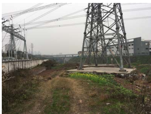
变电站东侧站外环境
