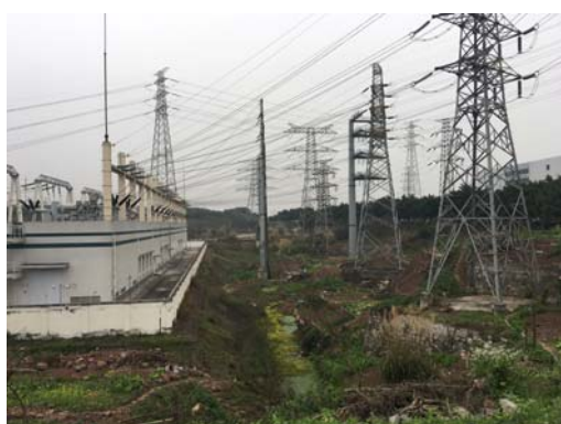
变电站西侧站外环境
